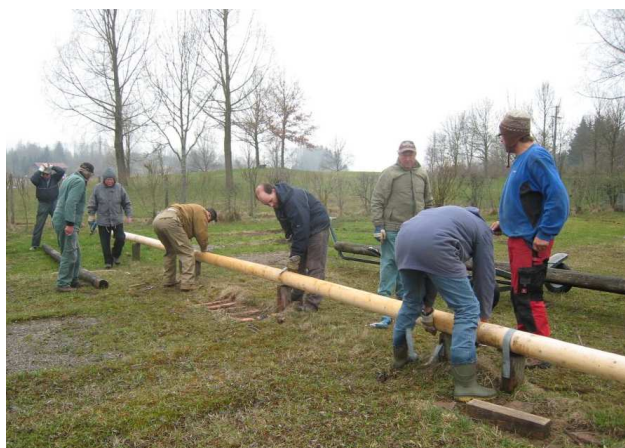
Anbringen der neuen Rundhölzer
